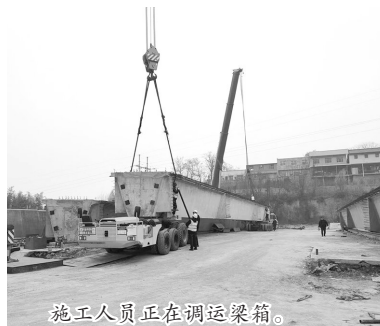
施工人员正在调运梁箱。
