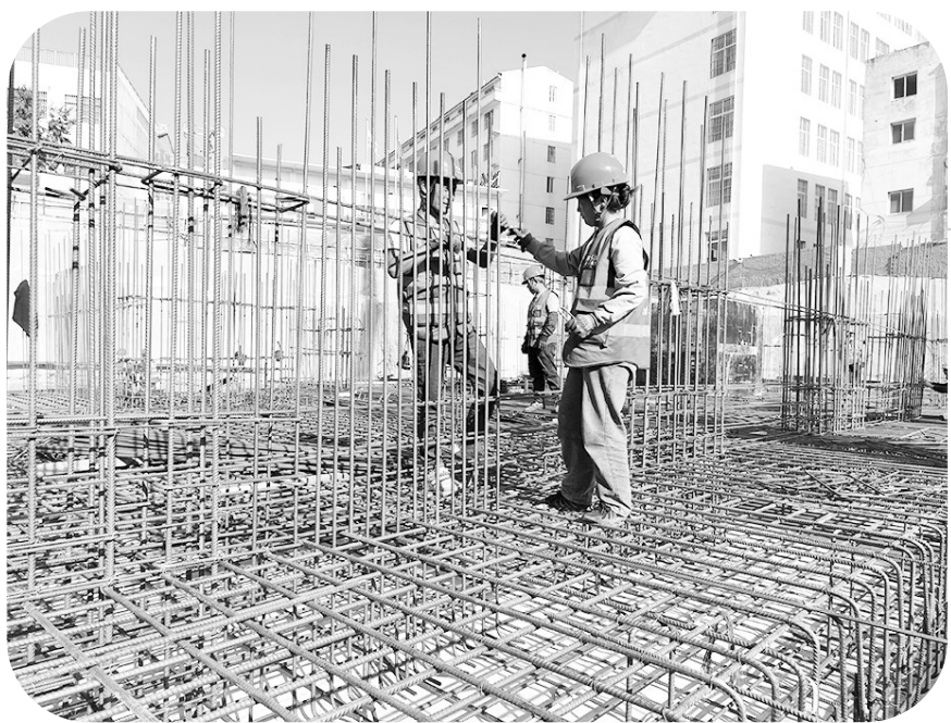
10月10日，永寿县一住宅楼项目正在建设当中。
