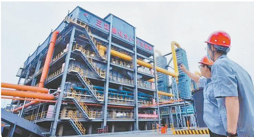
神木市正在建设中的干馏炉项目。(资料图)
