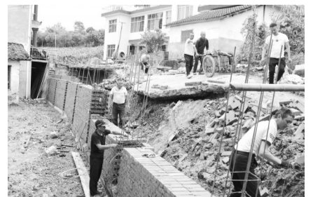
为做好水毁道路修复工作，保障群众顺利出行，连日来，汉中市南郑区梁山镇南寨社区组织群众对村间水毁道路进行全面维修。图为7月17日施工现场。何祥斌 摄
